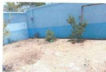
Foto 4: MEJORAMIENTO DEL ÁREA RECREATIVA
